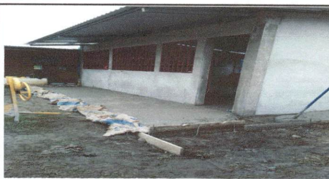
Foto 6: Elaboración de Estructuras
