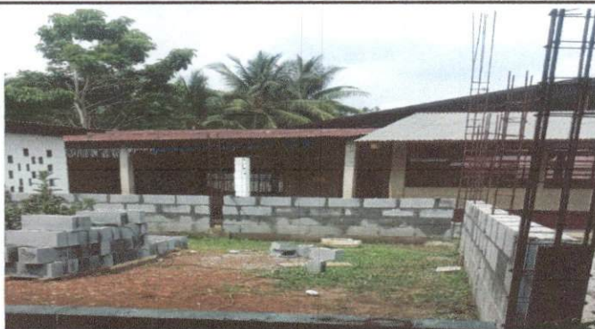
Foto 1: Continúa la construcción paredes del aula, que mide 6 metros por 8 metros.
