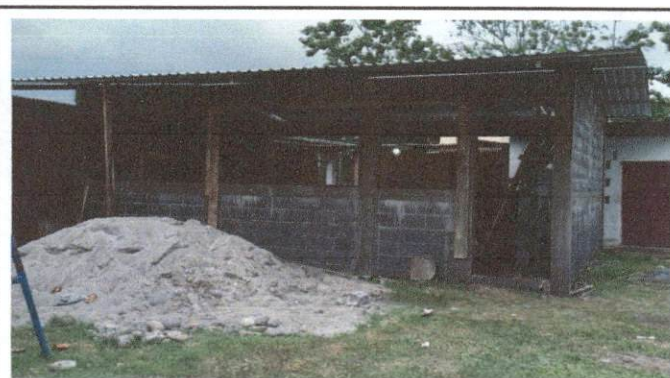
Foto 4: Colocacion de una puerta y 5 ventanas
