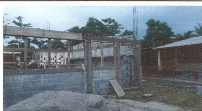
Foto 2: Se incluire la colocacion de 45 metros cuadrados de piso ceramico.
