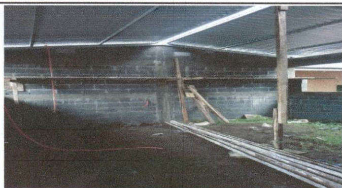
Foto 3: Se coloca el techo de lamina de 81 metros cuadrados, y sus sistema electrico.
